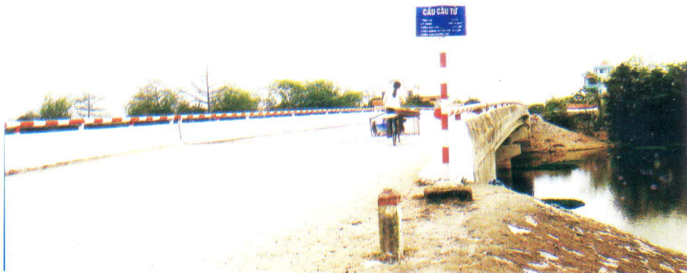
Cầu Yên Lệnh (ảnh trên), cầu Cầu Tư (ảnh dưới) Khánh thành đưa vào sử dụng năm 2004
